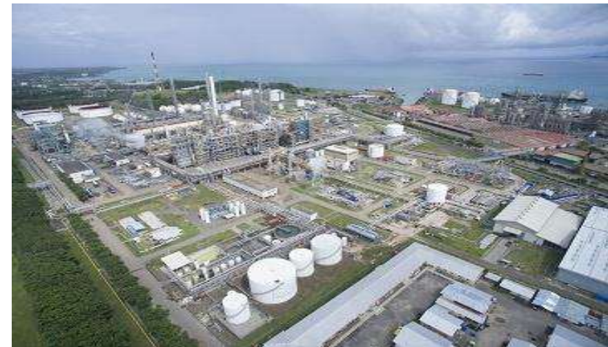
Komplek Pabrik utama CAP yang terintegrasi
